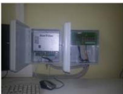
Site Control u svojoj bazi podataka ima definisani potrosnju svake zone rada sistema zalivanja a preko senzor dekodera dobija podatke o protoku vode i padavinama. Poseban software obrađuje sve primljene informacije i pokreće cikluse rada pojedinih zona zalivanja.
